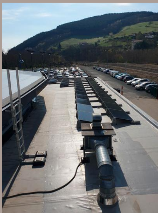
Vue d'un toit solaire
